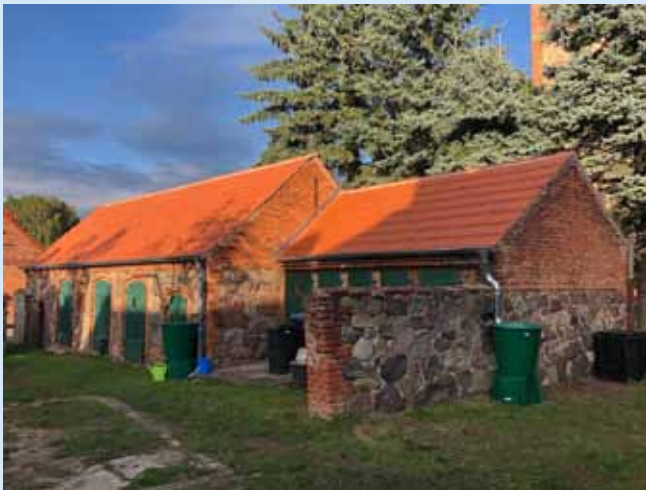
Sanierter Feldsteinschuppen in Vehlow zwischen Kirche und Gemeinderaum
